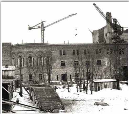
Восстанавливаемое здание драматического театра
