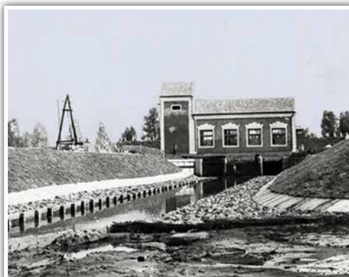
Мелиоративный канал насосной станции № 36 в Славском районе Калининградской области
