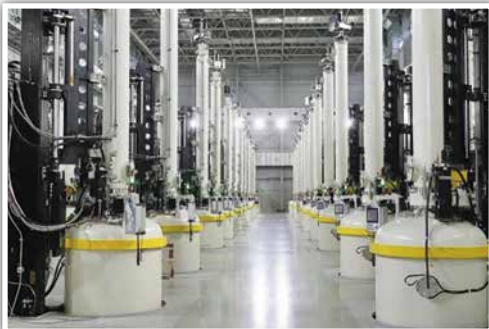
Завод «Энкор» по производству оборудования для солнечных батарей в Черняховске
