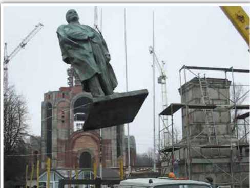
Демонтаж памятника В. И. Ленину на площади Победы; на заднем фоне строящийся собор Христа Спасителя
