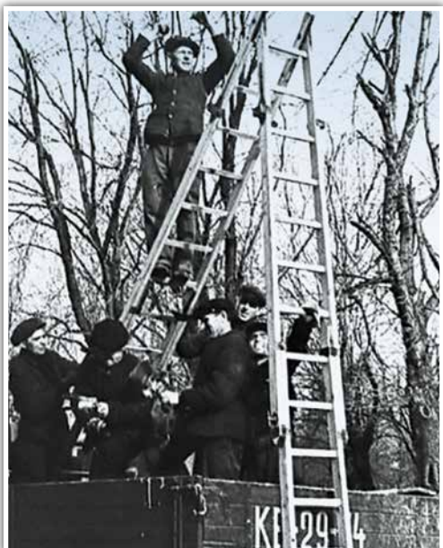
Установка уличного освещения в Калининграде
