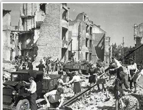
Субботник по разбору разрушенных зданий
