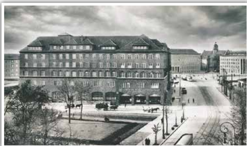
Здание в центре Кёнигсберга (сейчас площадь Победы в Калининграде), где в 1924—1925 годах располагалось советское консульство. В настоящее время — здание администрации областного центра
